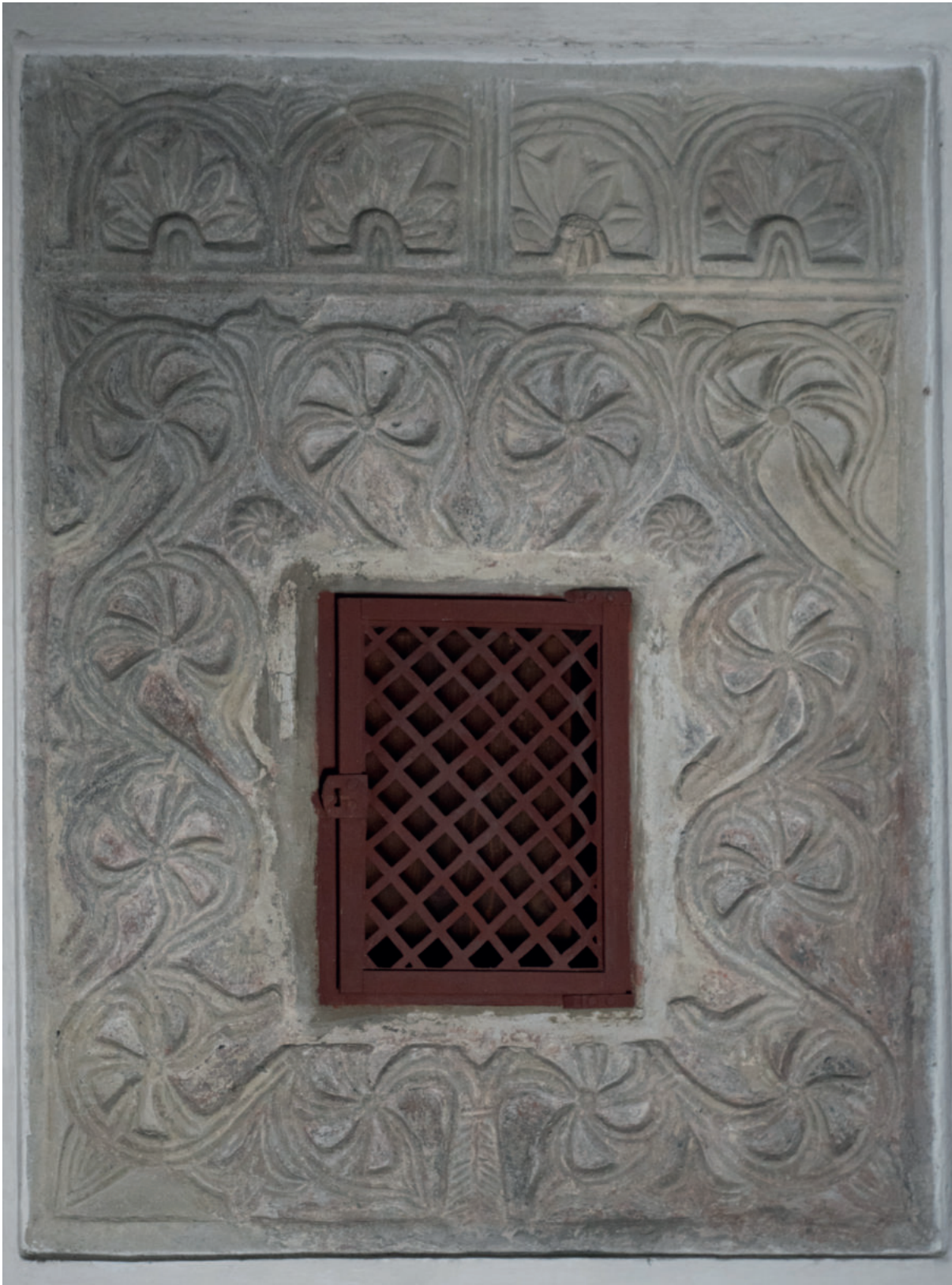
Abb. 24. Ornamentierte Sandsteinplatte in der Kirche von Gstadt. Das Material ist eindeutig den Vorkommen am Högl zuzuordnen. – Foto G. Lehrberger.
