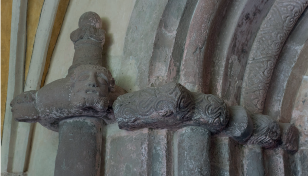
Abb. 22. Frauenwörth. Detail der Kapitelle der Säulen des Trichterportals mit roten Fassungsresten und an vielen Stellen durchscheinenden grau-grünen Partien des Högl-Sandsteins. – Foto G. Lehrberger.
