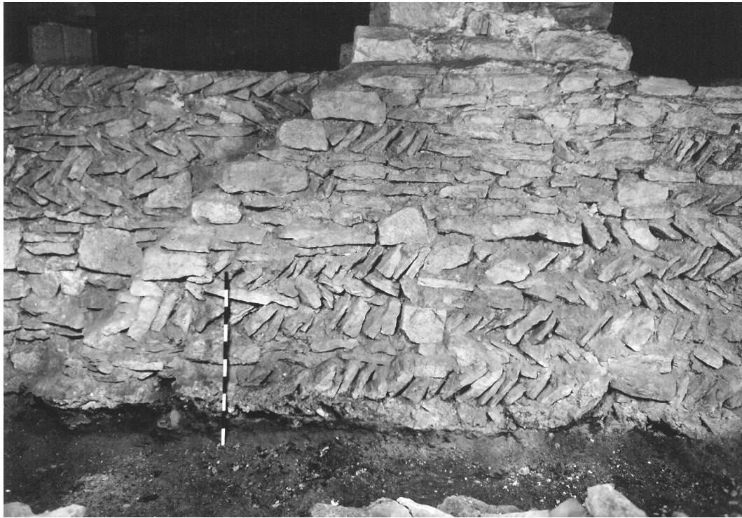
Abb. 18. Regensburg, Niedermünster. Treppenförmig ansteigende Abschnittsfuge in M 8 von Norden.
