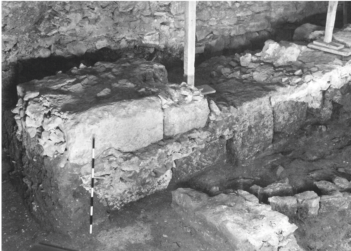
Abb. 13. Regensburg, Niedermünster. Ansicht M 65-Ost von Nordosten, Nordostecke des Campanilefundaments aus römischen Quadern mit kleinsteiniger Auszwicklung, dahinter M 8.
