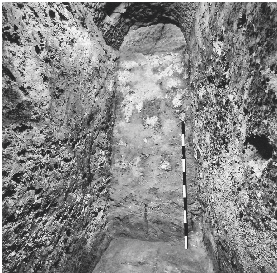
Abb. 16. Regensburg, Niedermünster. Innenansicht des gemauerten und verputzten Grabschachtes des Erhardgrabes nach seiner Erhöhung, mit aufgesetztem Sarkophagdeckel.
