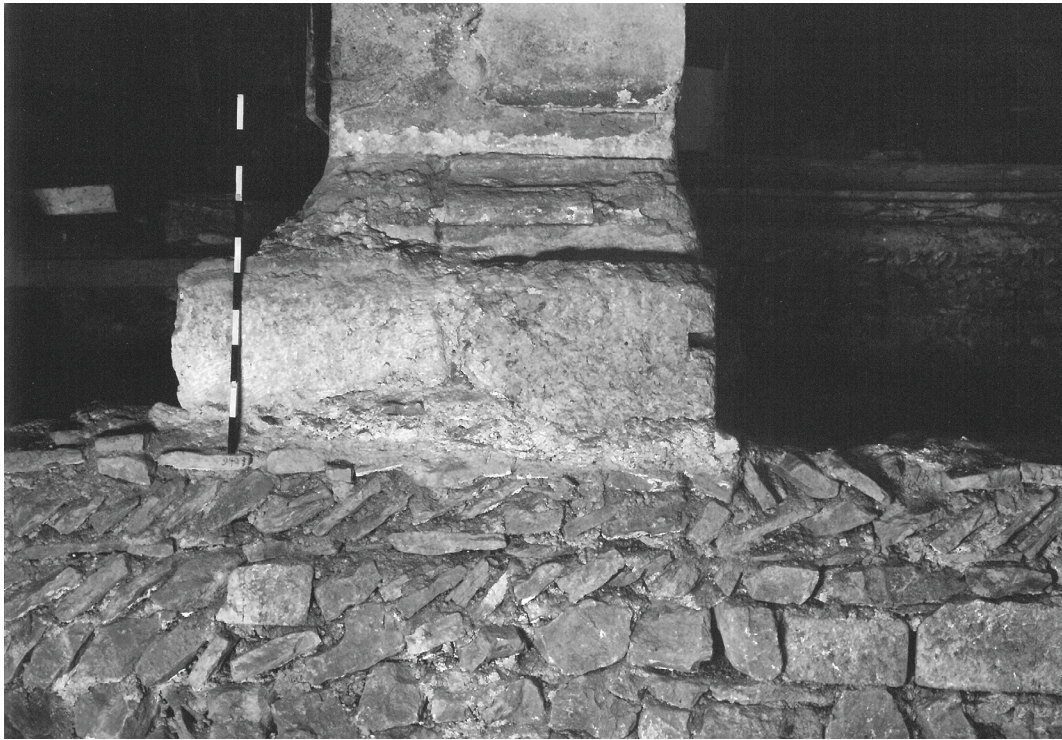
Abb. 17. Regensburg, Niedermünster. M 8 mit Fundament für Pfeiler 15 von Norden.
